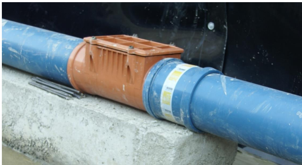
Obr. 7 Čistící kus s odnímatelným víkem na drenážním potrubí
